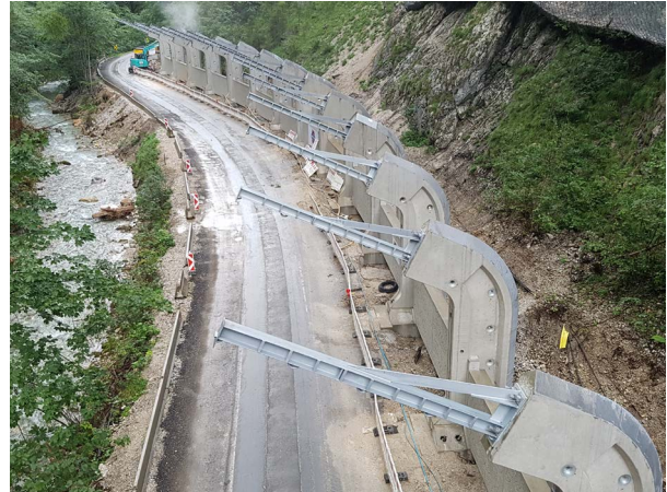
Steinschlagschutz im Bau Rockfall protection under construction
